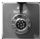
8-pins AO-uitgang op het generatorpaneel
